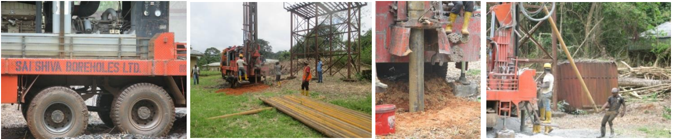
Equipment kommt aus Indien Bohrgestänge für 140 meter tiefe Bohren Bohrstangen auswechseln
