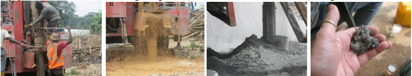
Bohrstangen befestigen Erstes Wasser Granitstaub mit Wasser versetzt.
