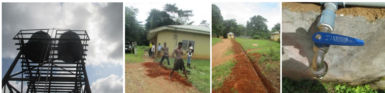
Wassertanks anschliessen, Rohre verlegen und Wasserhähne installieren.
