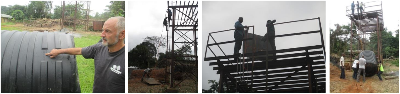
Zwei 3000 Liter Tank müssen auf den Turm, doch zuerst Stahlplatten setzen.
