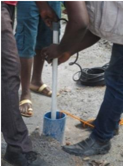
Tauchpumpe und Rohre einsetzen.
