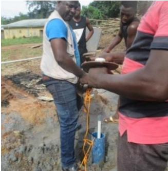
Tauchpumpe und Rohre einsetzen.
