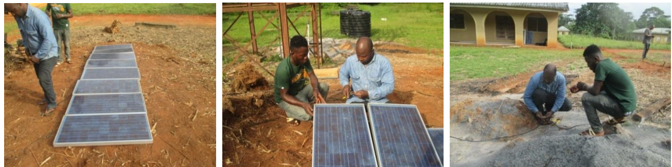
Solarpanel auslegen und anschliessen für den ersten Test der Solaranlage für die Wasserpumpe.
