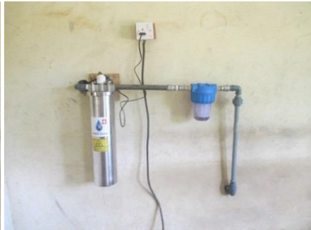
Kernstück der Anlage, Aqua Pura Waterflow Anlage ist montiert und angeschlossen. Informationen über diese fantastische Wasserreinigungsanlage finden sie unter www.aqua-pura.org .
